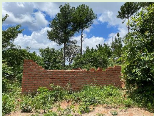
CBCC の隣に 5 歳児以下のクリニックを建設中
